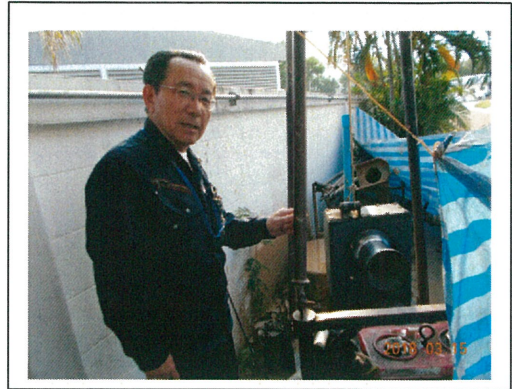
ボーリングマシンで井戸設置
