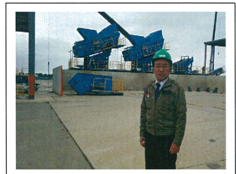
プラント解体撤去工事
